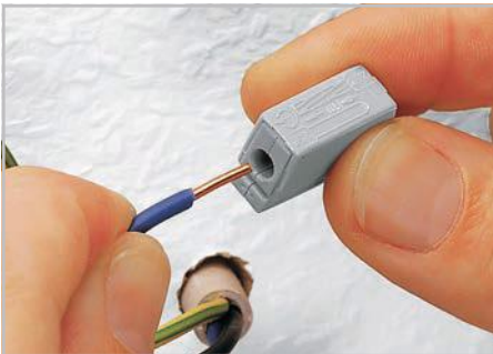
Страна монтажа: вставьте зачищенный одно-проводочный проводник в круглое отверстие до упора.
