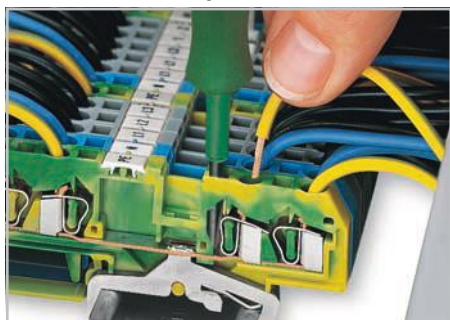
Вставка проводника при помощи отвертки.
