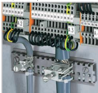
Установка на несущую рейку со специальной перфорацией
